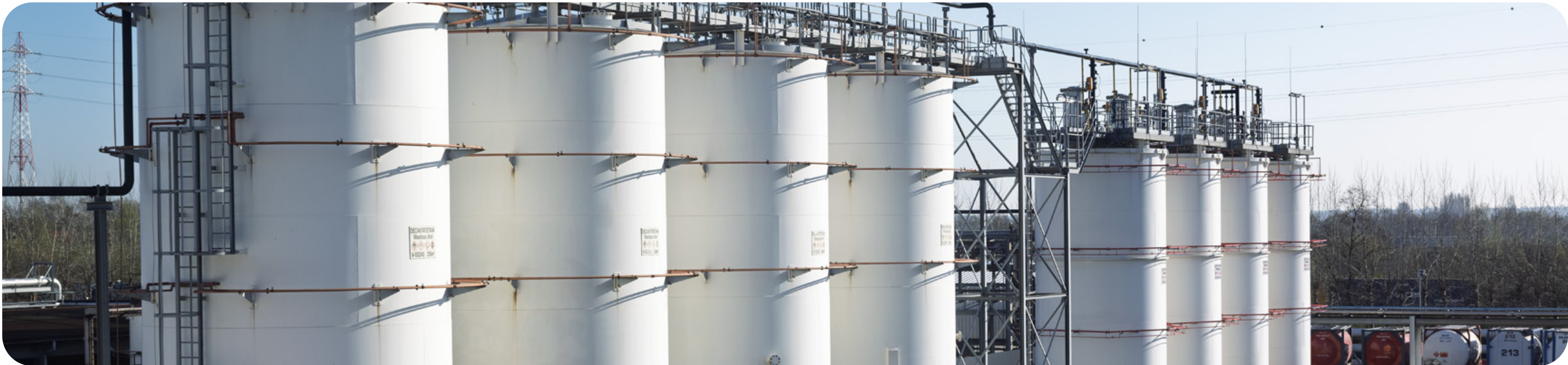
Indaver aanvaardt vloeibare afvalstoffen uit de industrie in haar tankenpark voor thermische verwerking in de draaitrommelovens.
