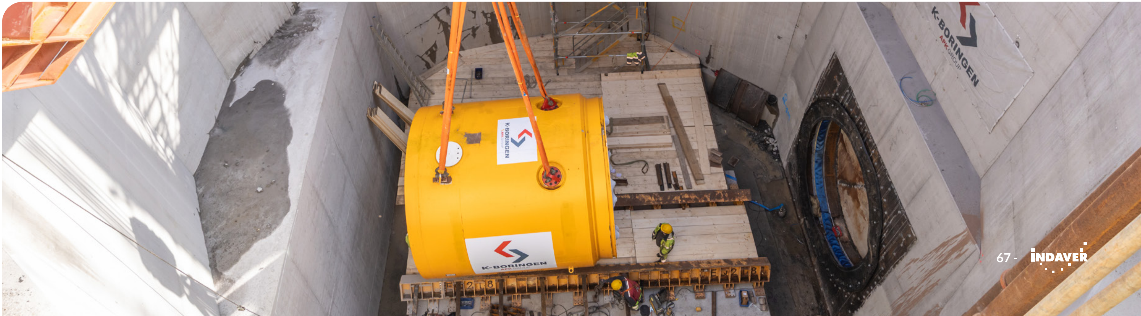
De boormachine wordt in gereedheid gebracht en zal in 2025 de tunnel onder de Schelde voltooien.
