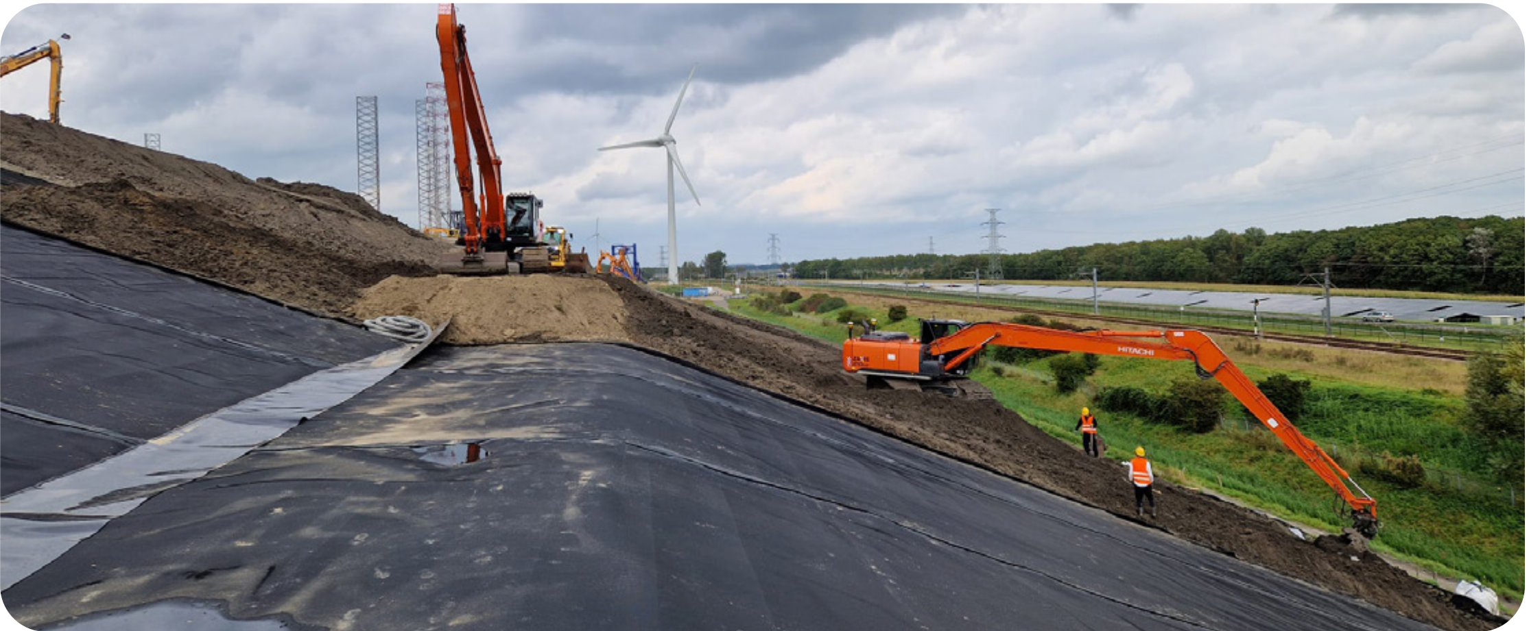
De stortplaats in Noord- en Midden-Zeeland wordt afgedekt.
