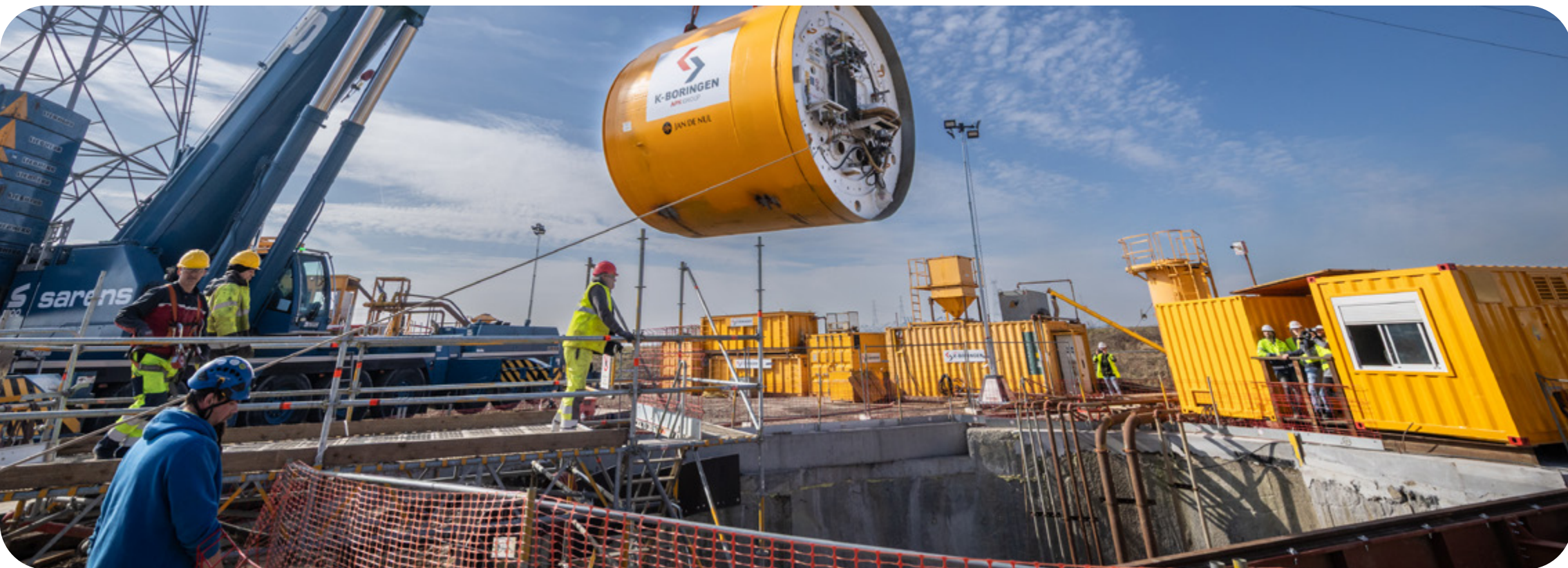
Aankomst van de tunnelboormachine in Antwerpen voor de bouw van de langste microtunnel van België onder de Schelde, ter uitbreiding van ECLUSE.
