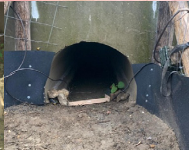
Ecotunnel in het havengebied
